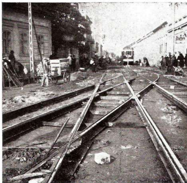
Lucrări de linie
