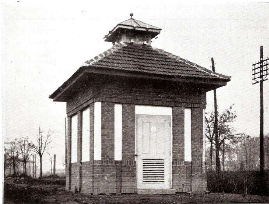
Casă de transformator
